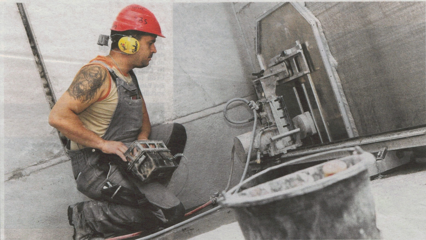
Mit Präzisionsgeräten bohren BBS-Arbeiter durch dicksten Beton.
